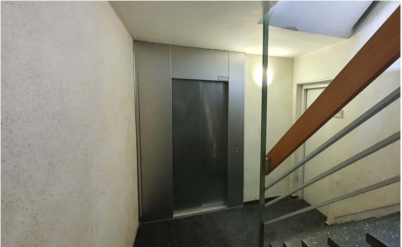
Fahrstuhl Keller Tiefgarage
