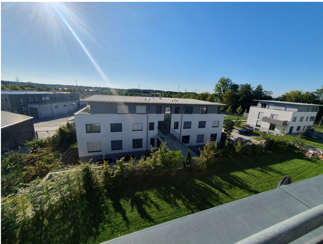
Blick von Dachterrasse
