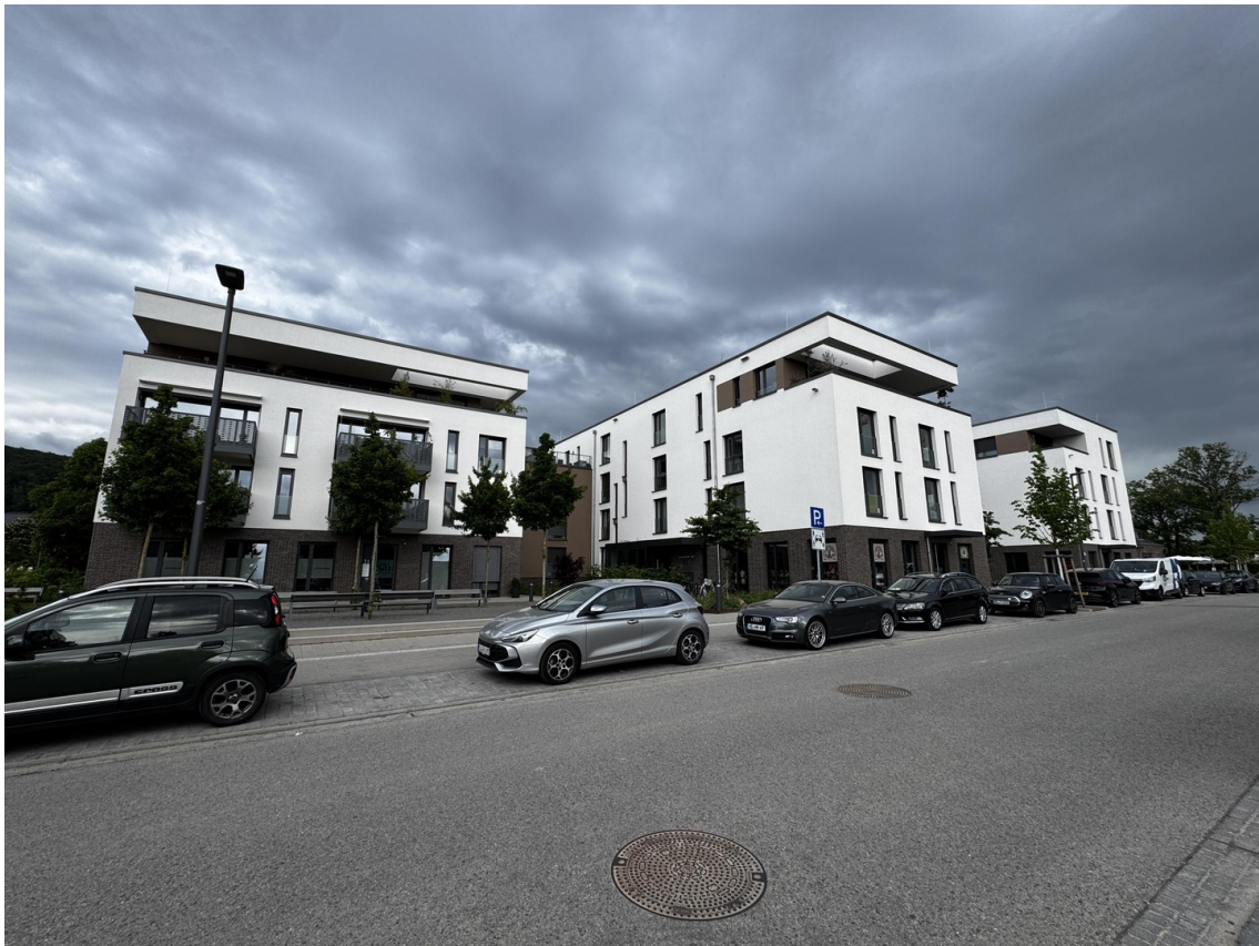
Ansicht von Nordwest
