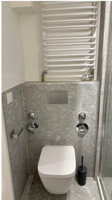
Bad Detailaufnahme Toilette
