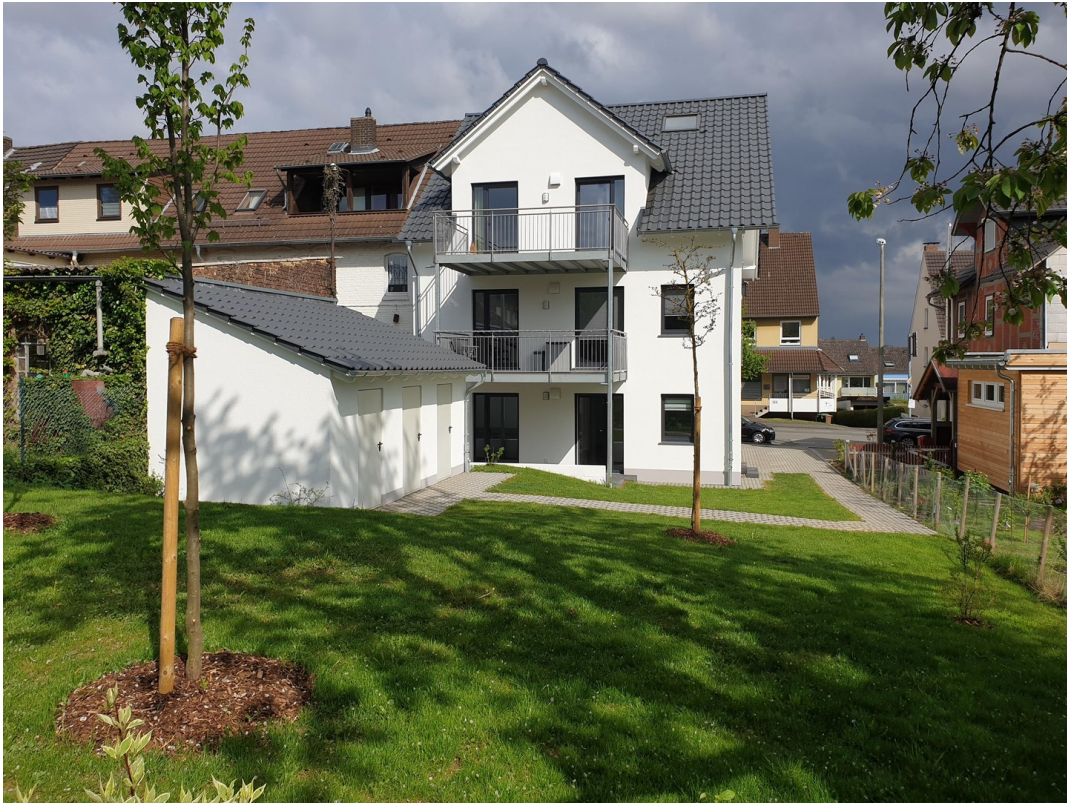
Westansicht mit Abstellräumen
