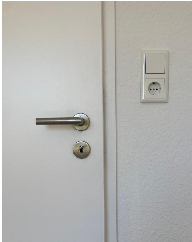
Detail: Schalter & Klinken neu
