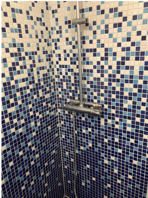
Bad: Mosaikarbeiten Wand
