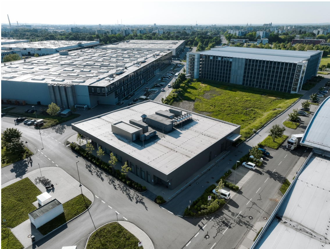
Richtung Innenstadt, Parkhaus
