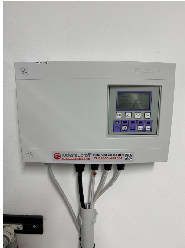
Rückstapumpen Steuerung
