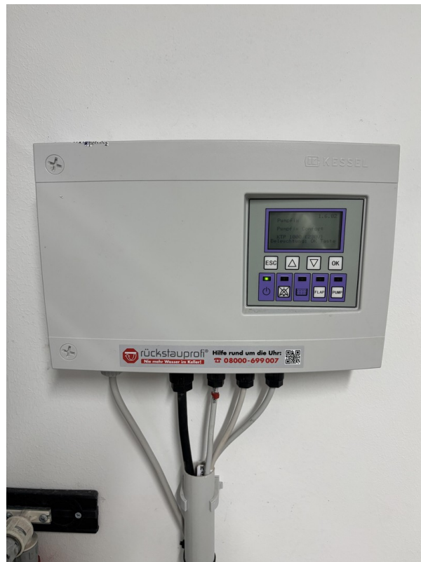
Rückstapumpen Steuerung
