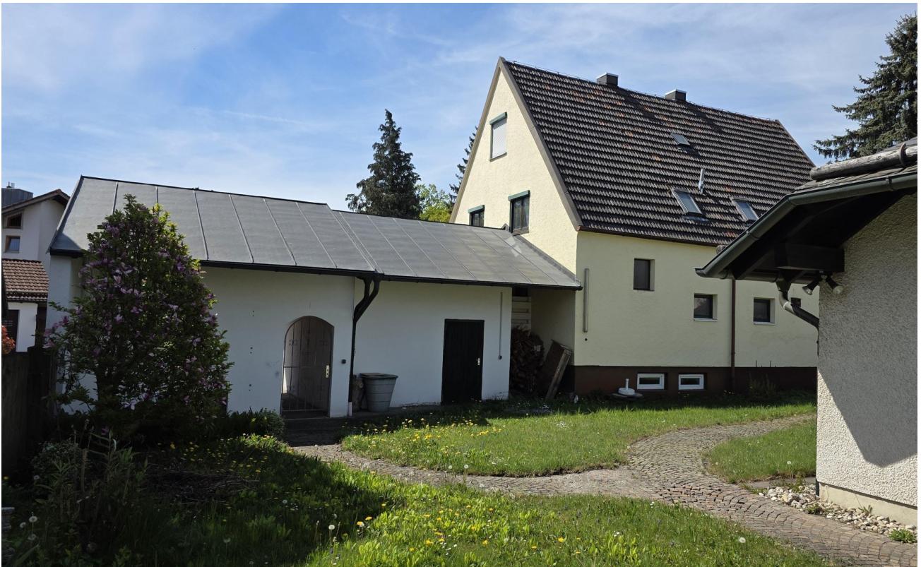
Altbestand mit Garage und carp
