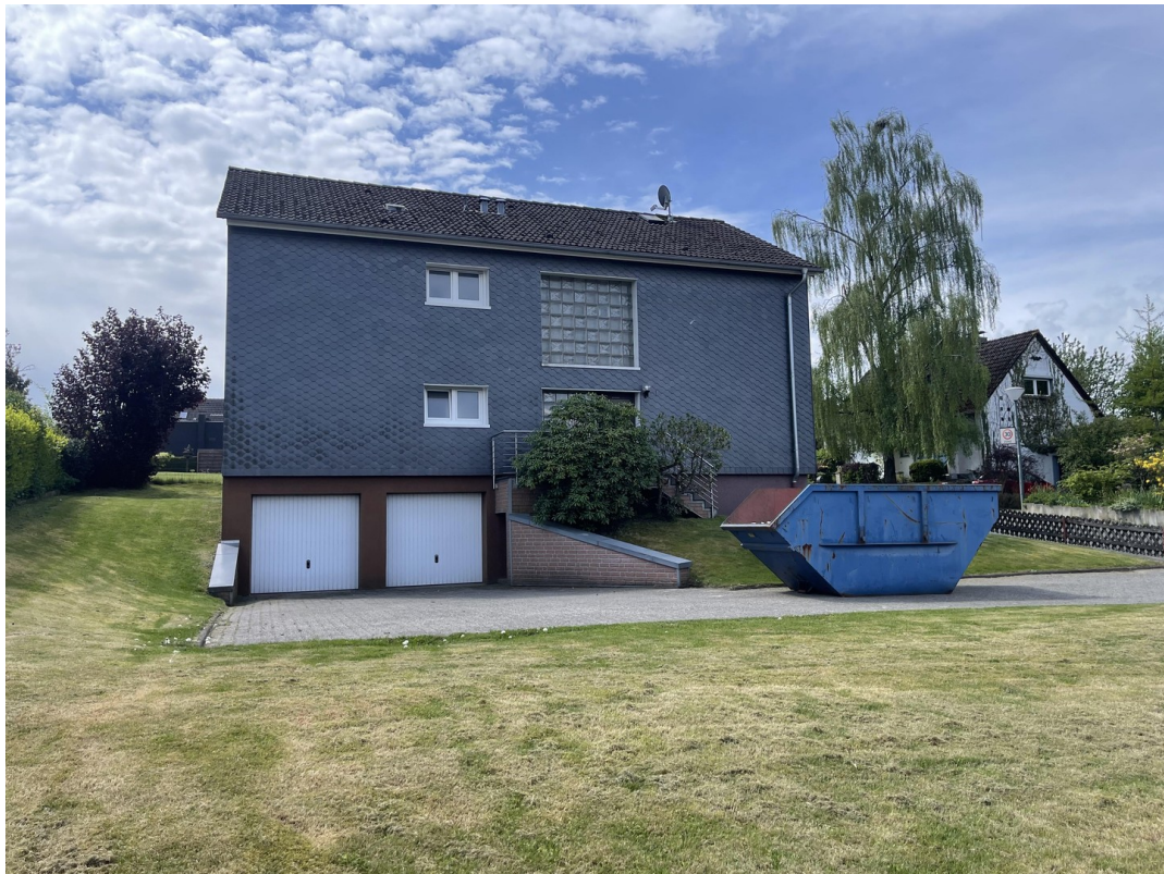
Ansicht Haus Front
