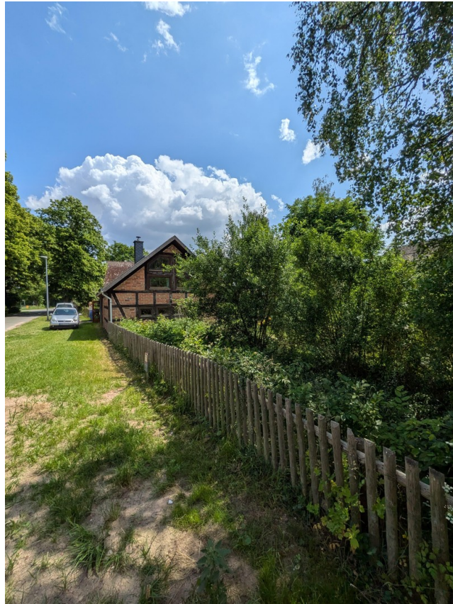
Blick auf Wohnhaus
