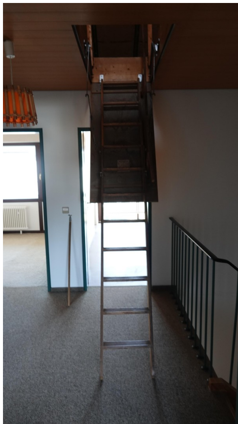
Aufgang zum Dach
