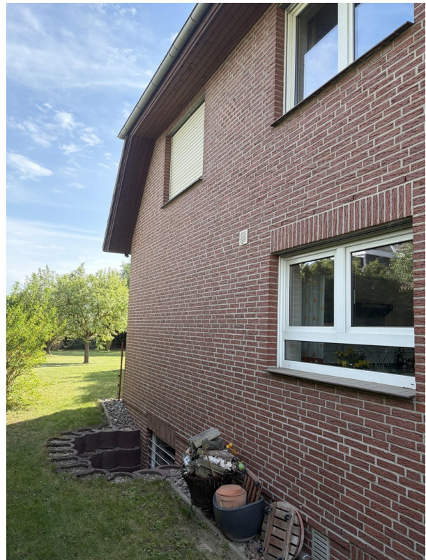
Souterrain Fenster Wohnkeller
