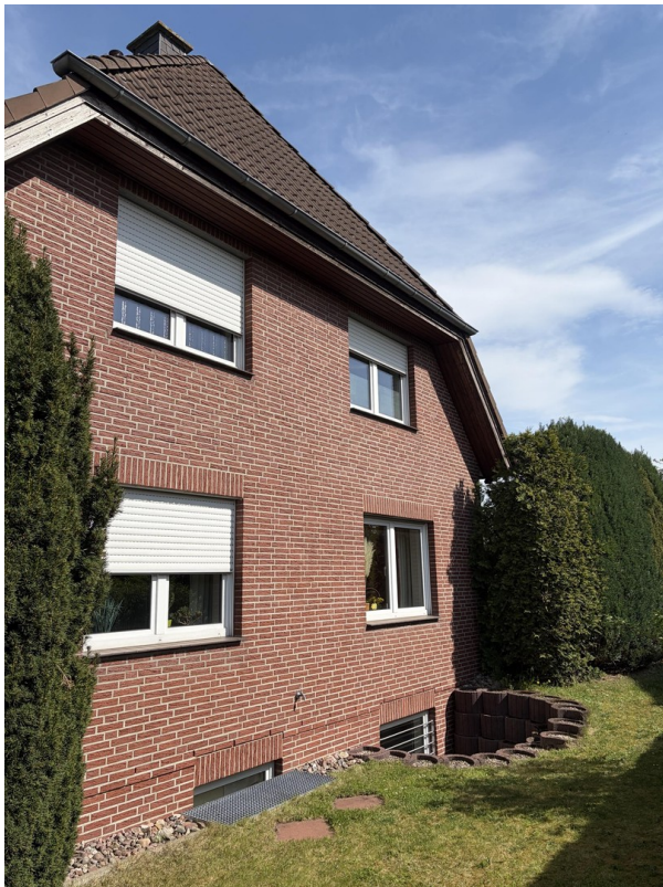
Souterrain Fenster Wohnkeller
