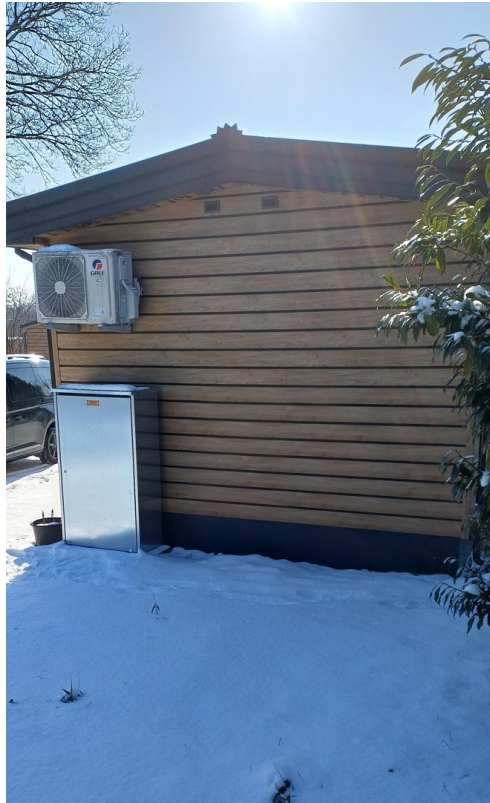
Gasschrank und Klimaanlage
