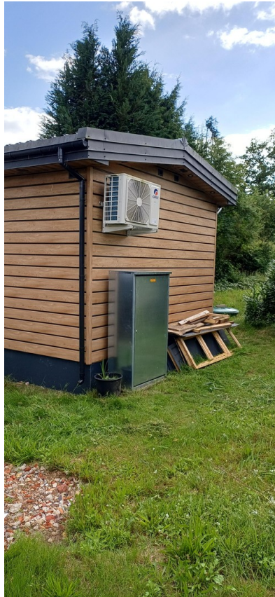
Schrank für die Gasflaschen
