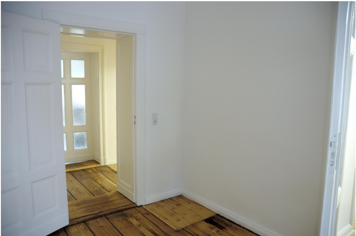
Blick Büro kl. Flur und Teek.
