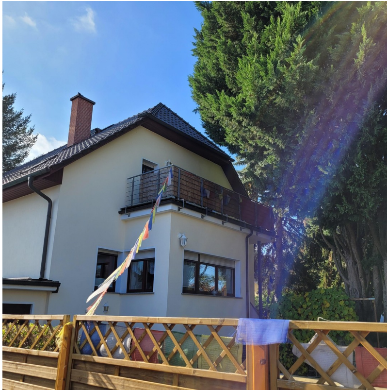
hintere Hausansicht mit Balkon
