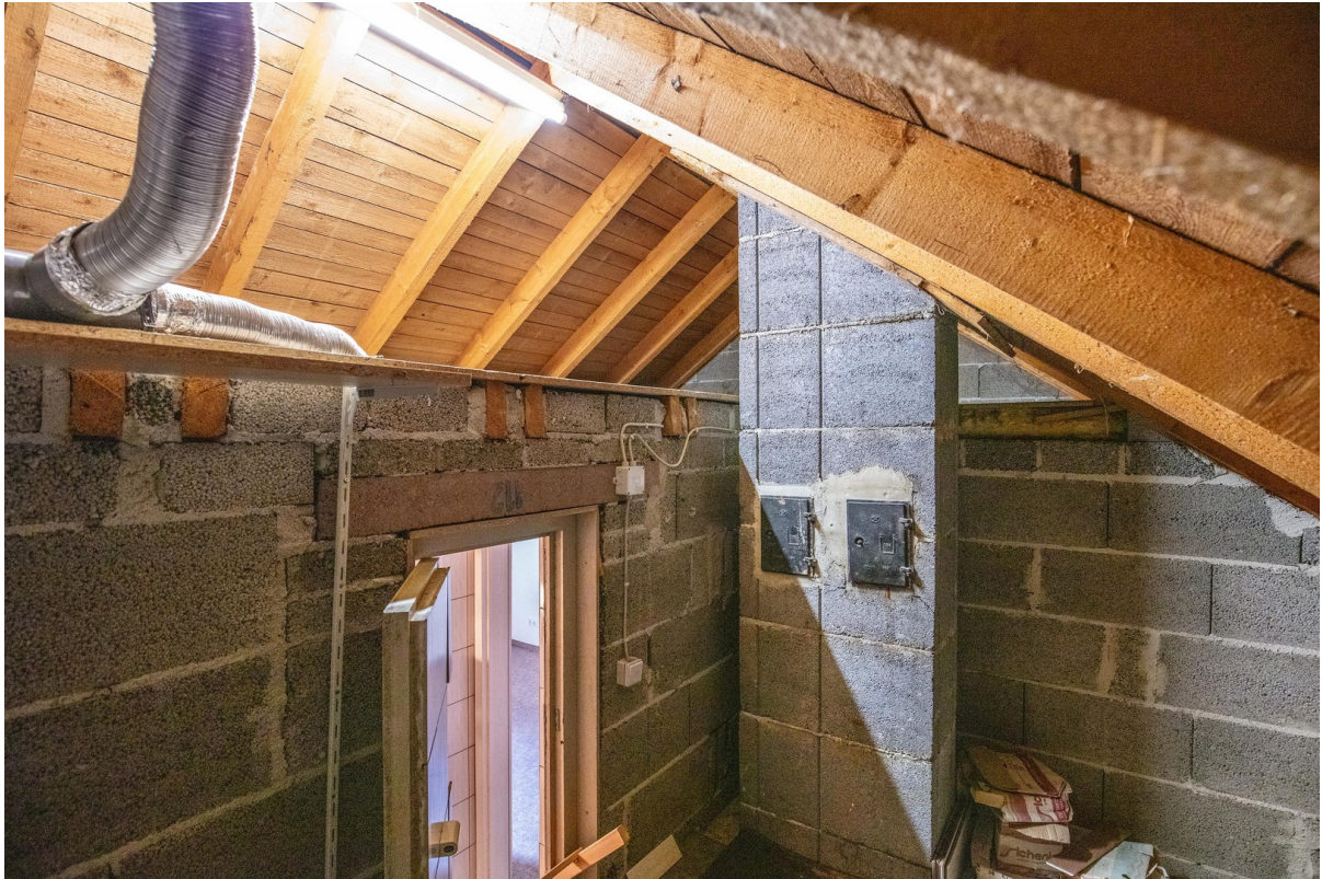
Dachboden (ein Teil davon)
