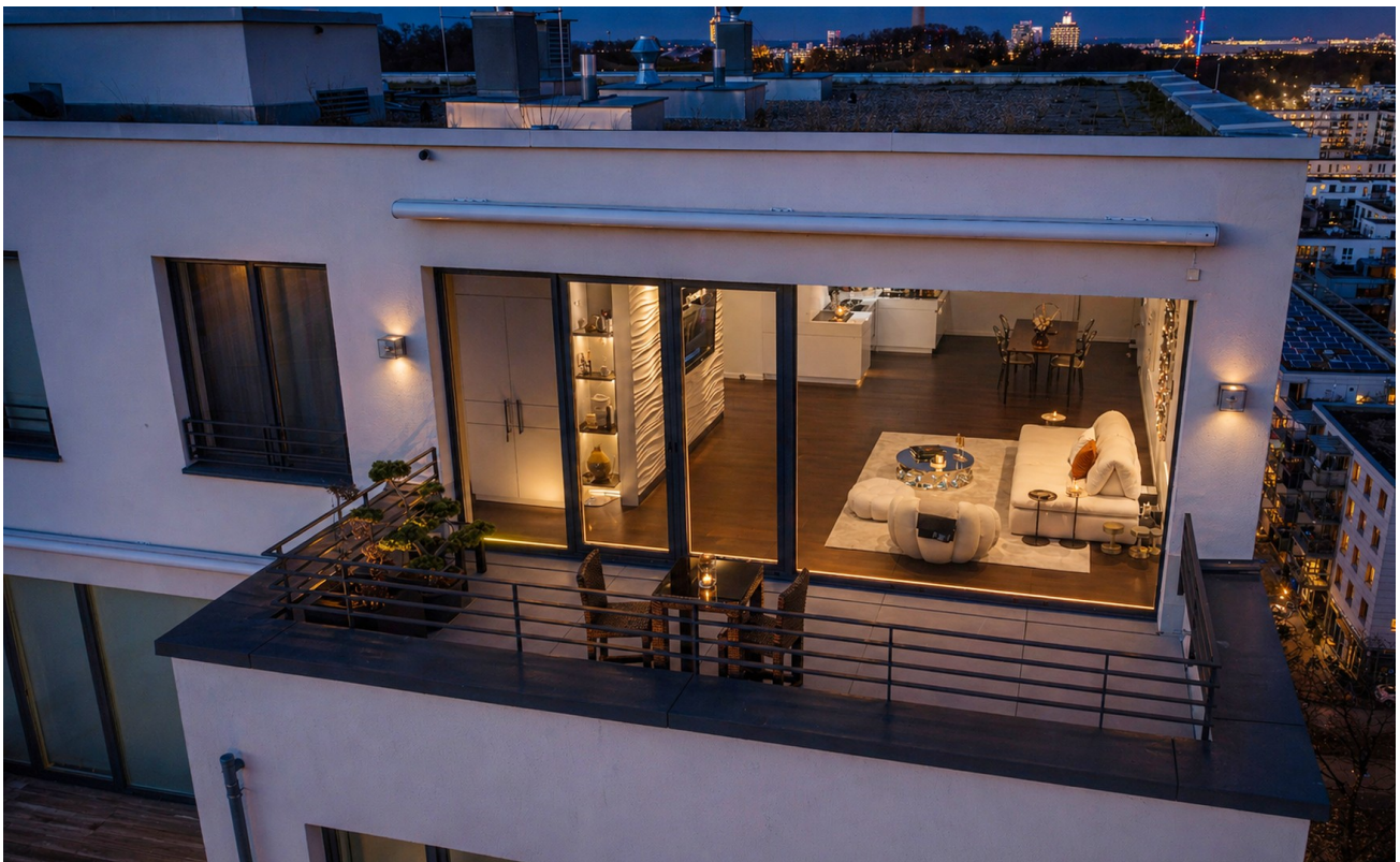
Ansicht Dachterrasse Abend
