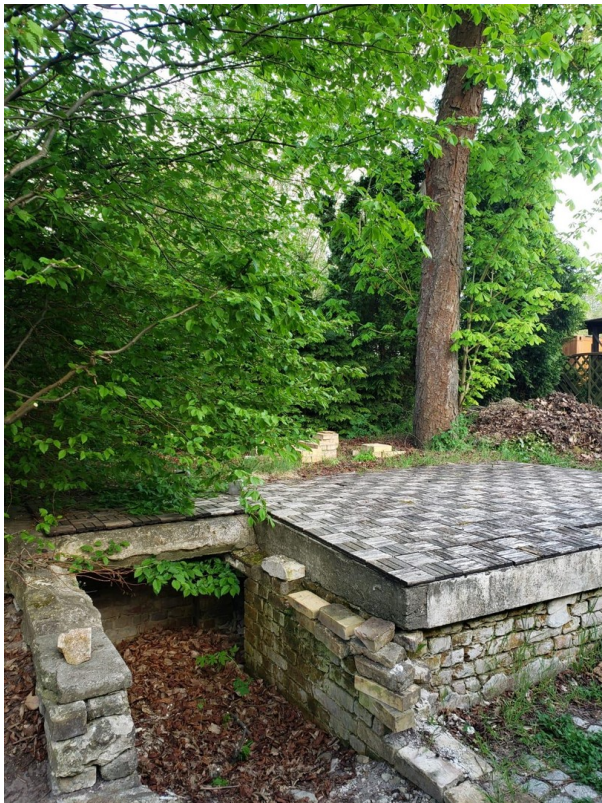
Ecke Süd-West (Bunker)
