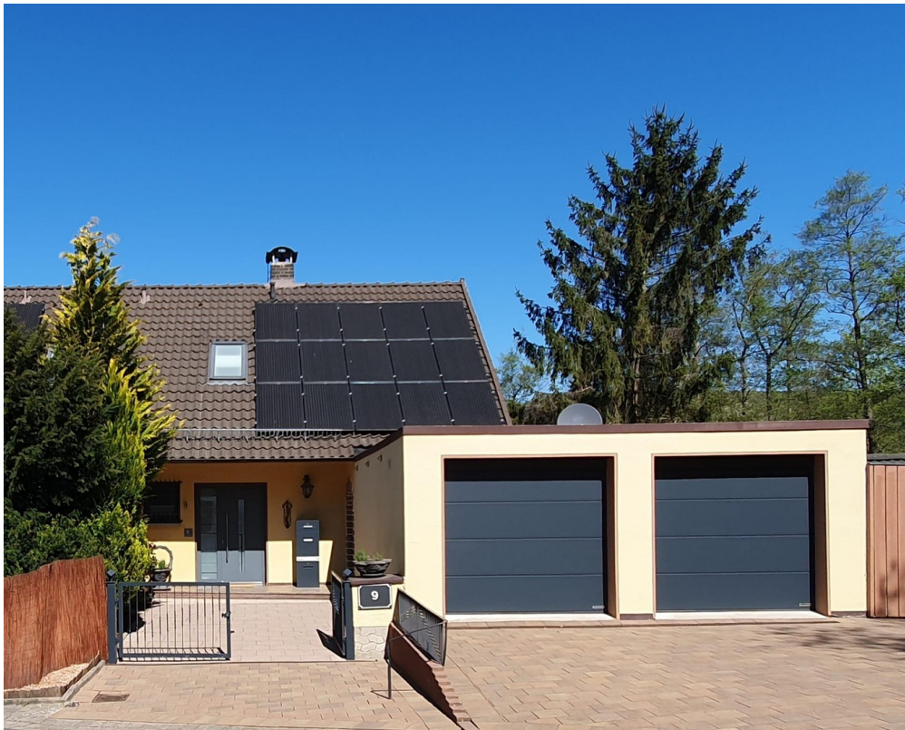
Doppelgarage und PV-Anlage
