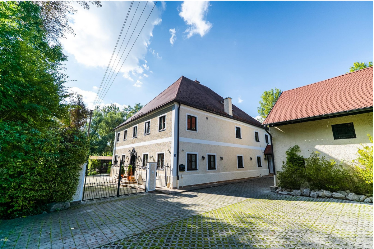
Ansicht Haupthaus von Osten
