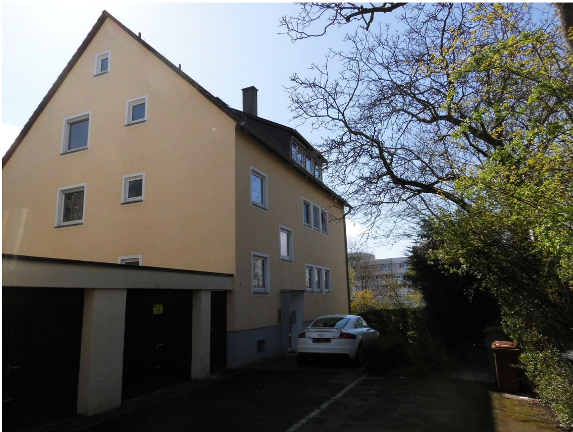
Ostansicht mit Eingang
