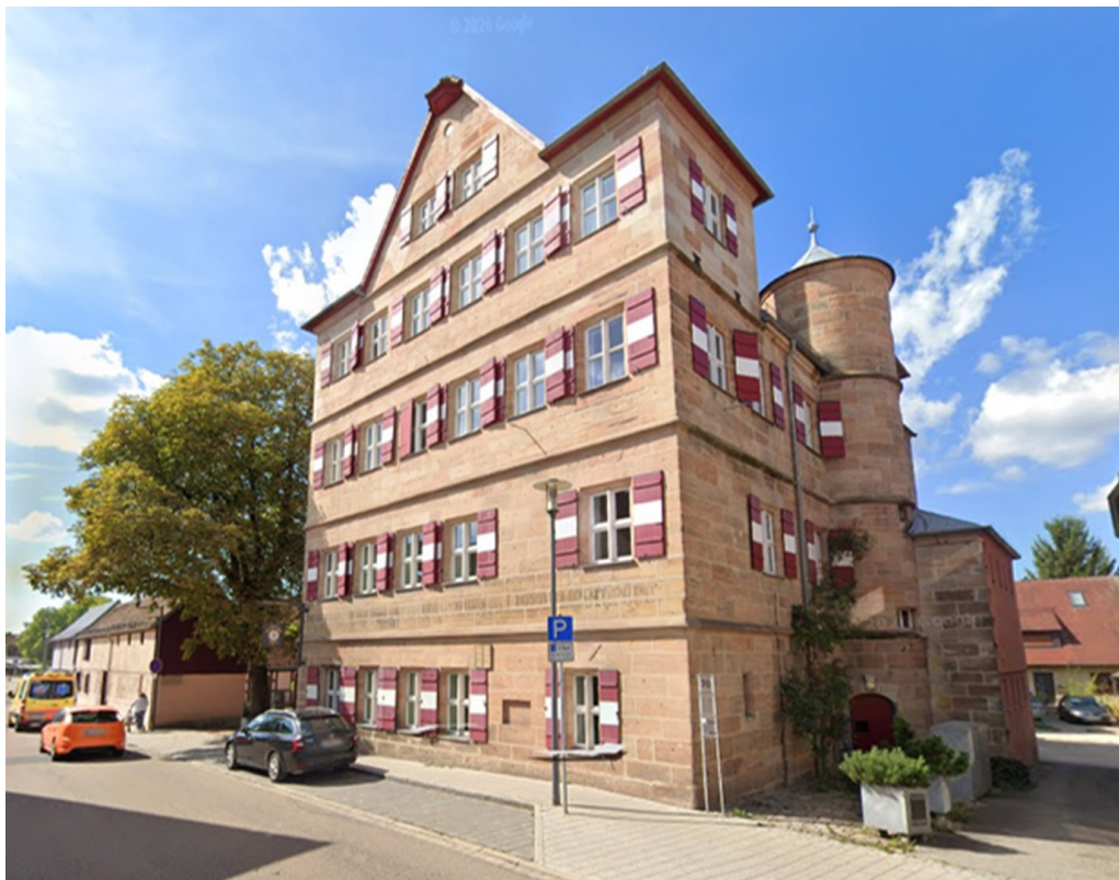
Fassade an der Hauptstraße
