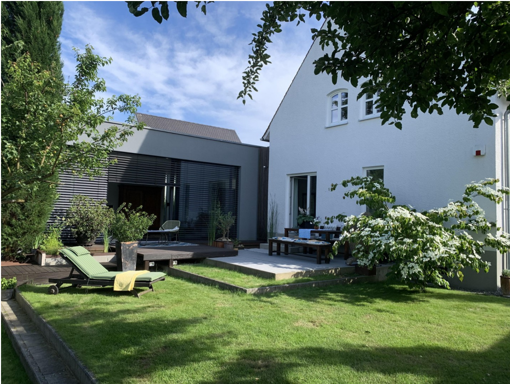
Siedlerhaus mit Anbau
