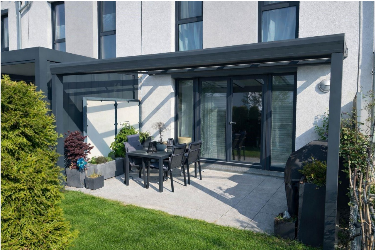
Ansicht Süden Terrasse
