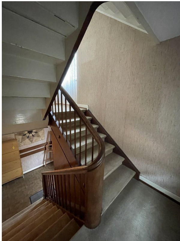
EG Treppenhaus in OG
