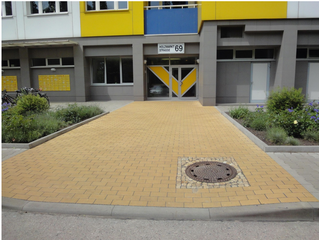
Eingang mit Grünanlage
