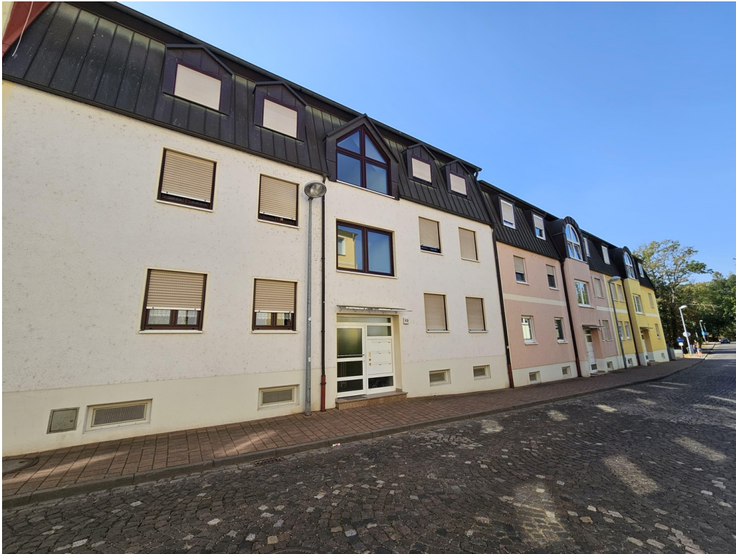
Gebäude von aussen
