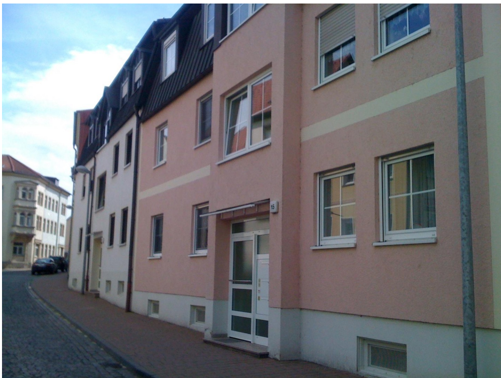
Gebäude von aussen
