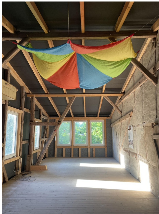
Ausbaureserve im OG
