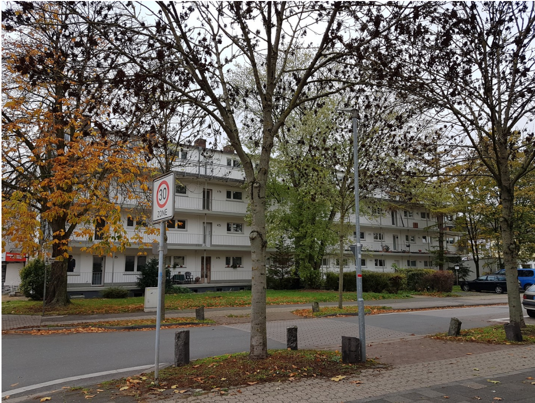
Ansicht Gebäude Allmendestraße
