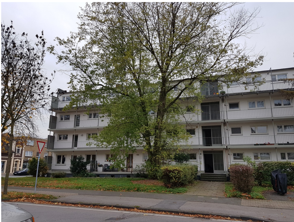
Ansicht Gebäude Allmendestraße
