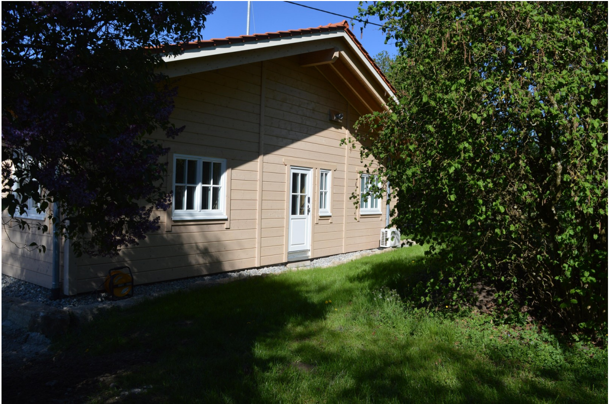
Wohnhaus von Südwesten
