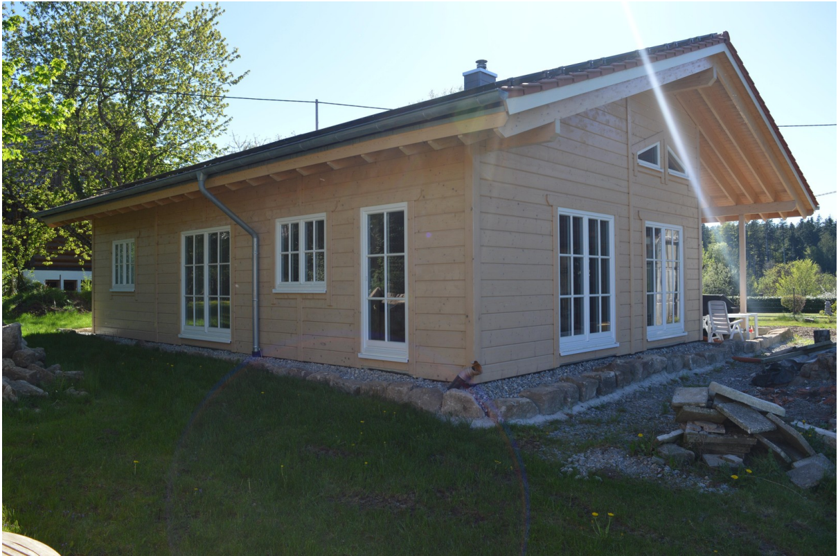
Wohnhaus von Nordosten
