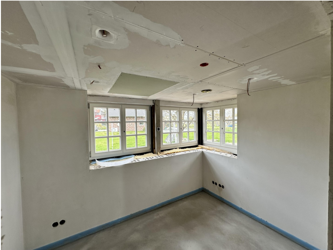
Arbeitszimmer im EG (ca. 6 qm)
