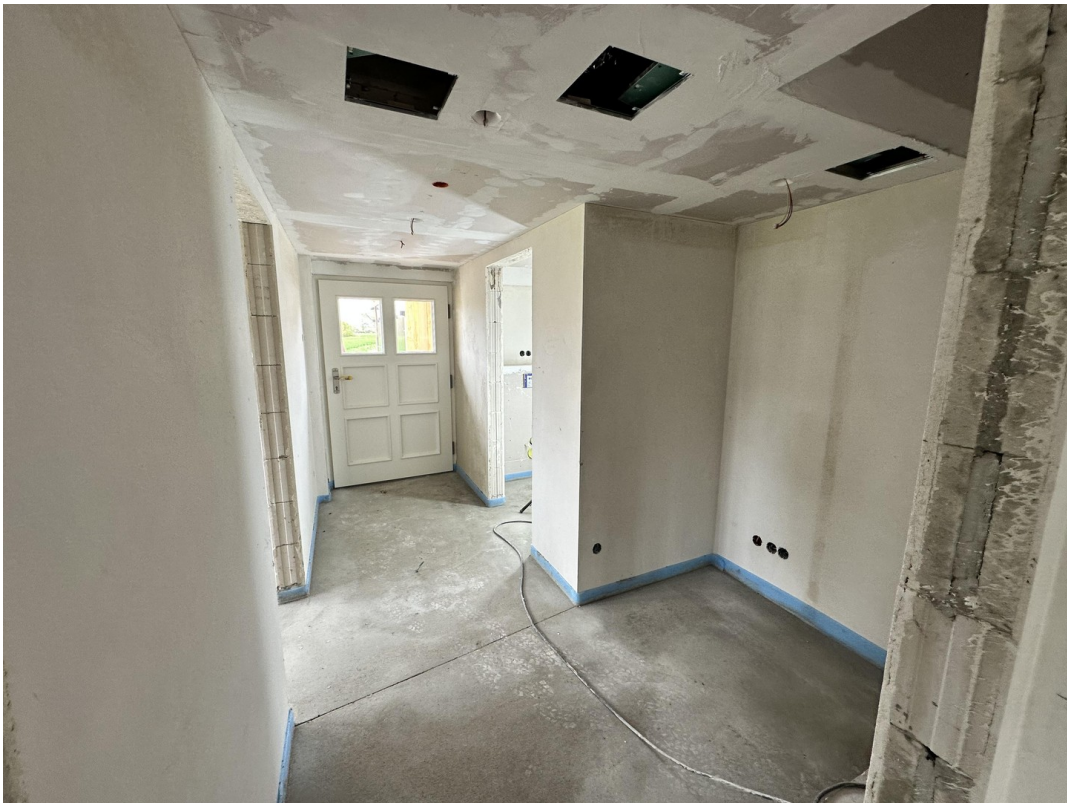
Eingangsbereich (ca. 7 qm)
