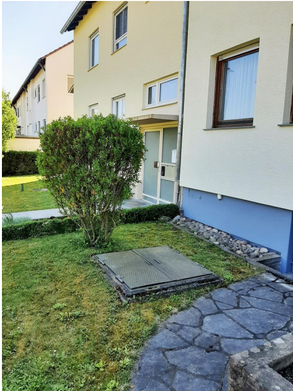
Vorgarten mit Ölschacht
