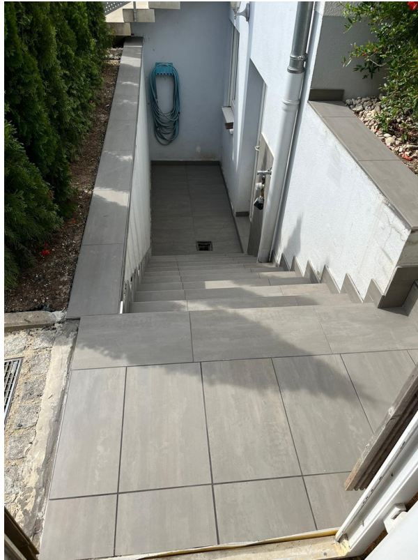
Abgang Keller Außen
