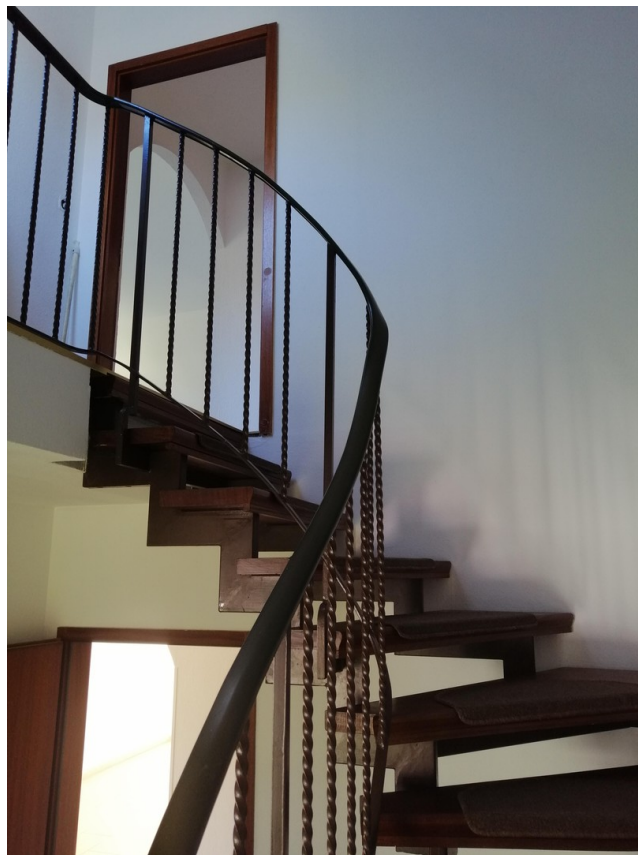
Treppe zum OG
