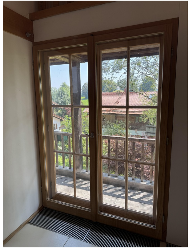
Blick auf Süd-Balkon
