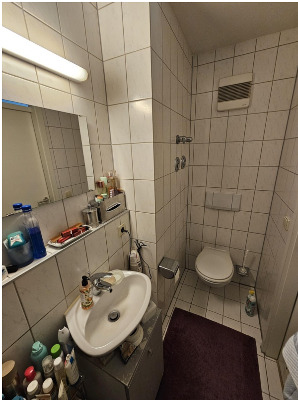
Dusche und WC (2)
