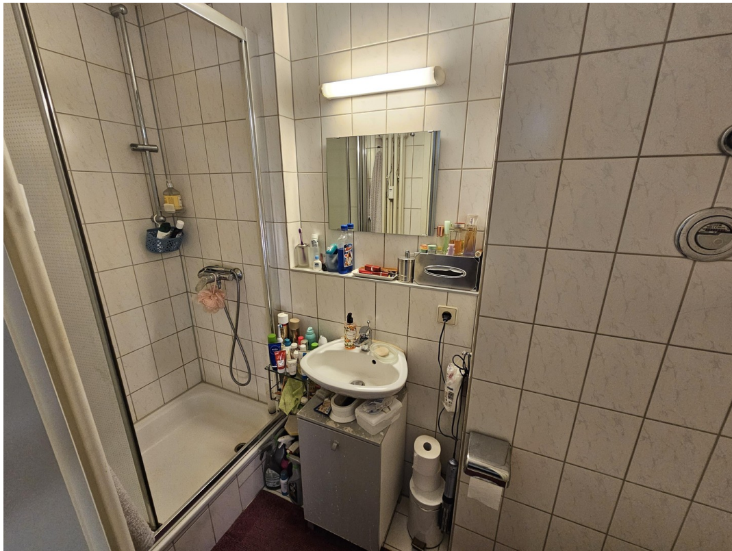
Dusche und WC (1)
