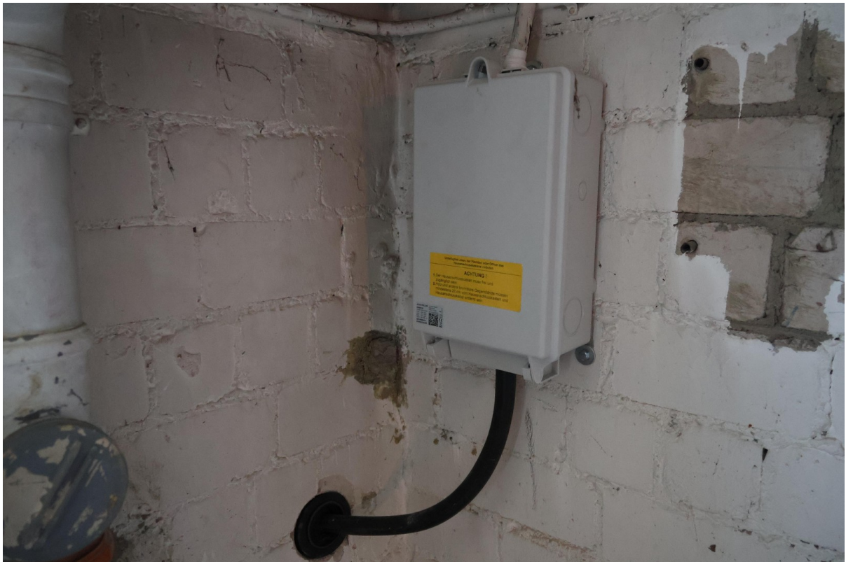
Stromanschluss Keller neu
