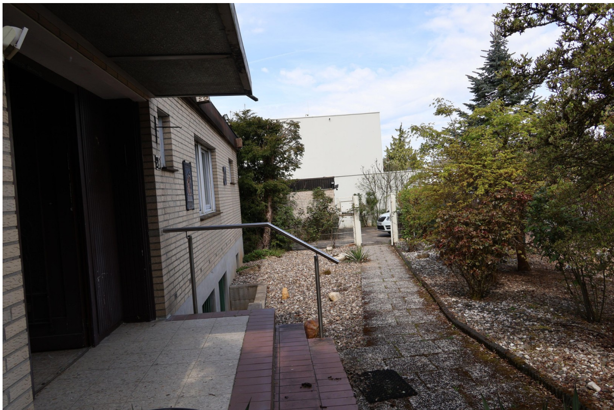
Bereich vor Eingangstür
