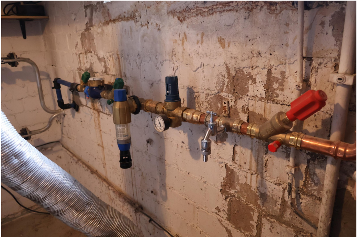
Wasseranschluss Keller neu
