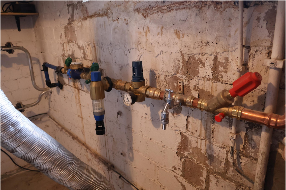
Wasseranschluss Keller neu
