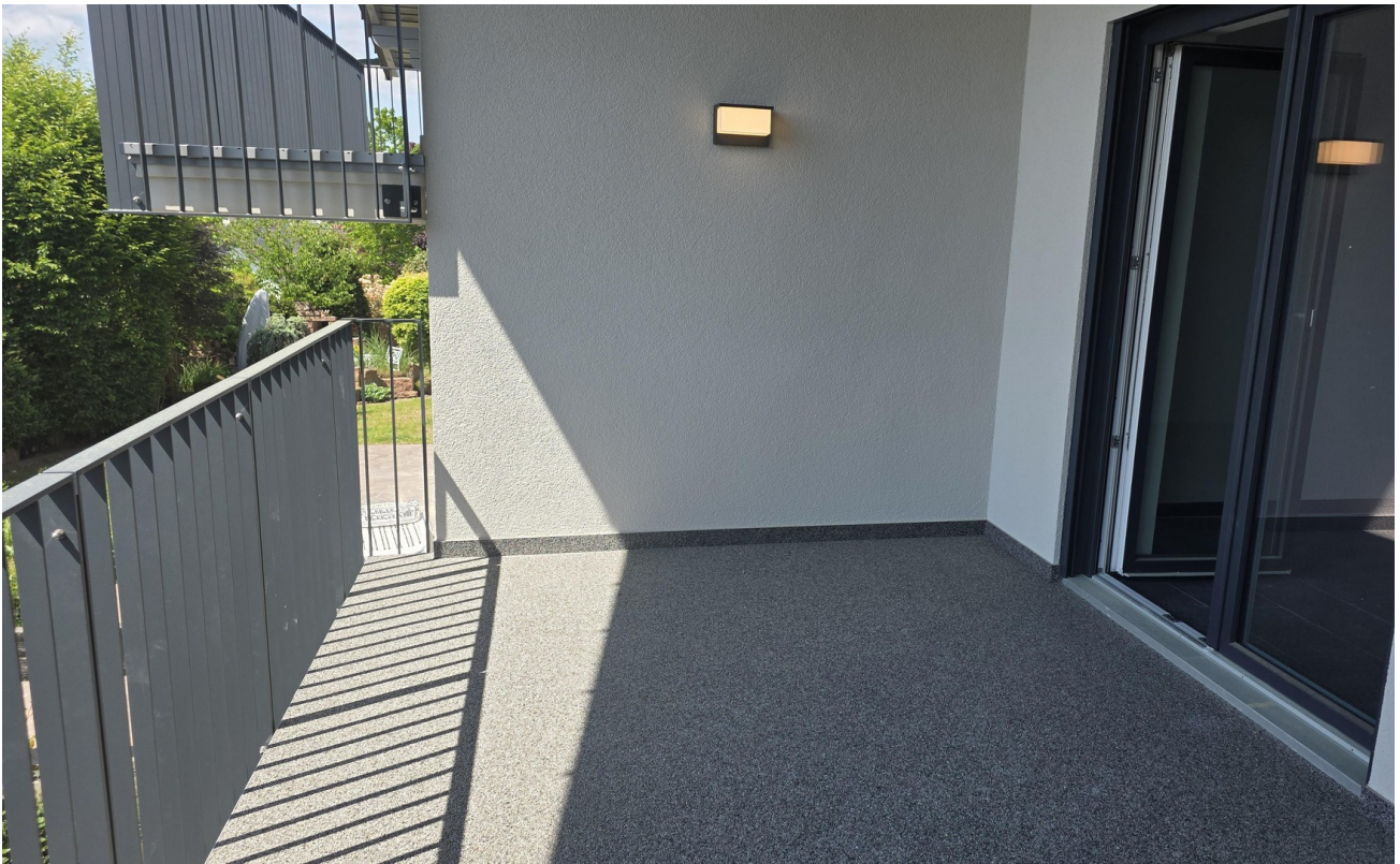
Balkon mit neuer Beschichtung
