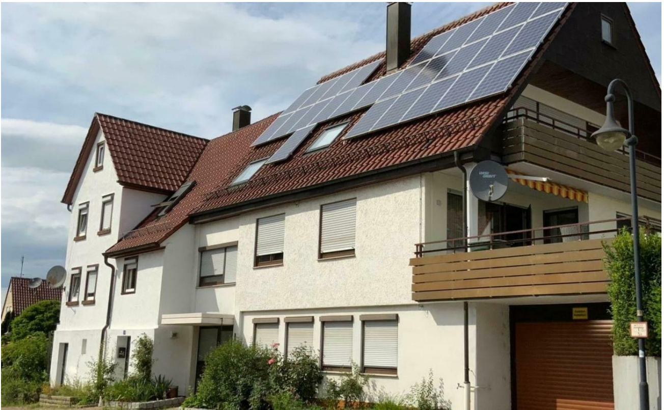
Hausansicht mit PV-Anlage
