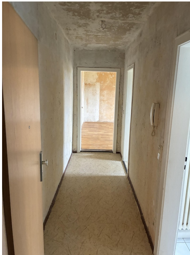
Flur mit Gegensprechanlage
