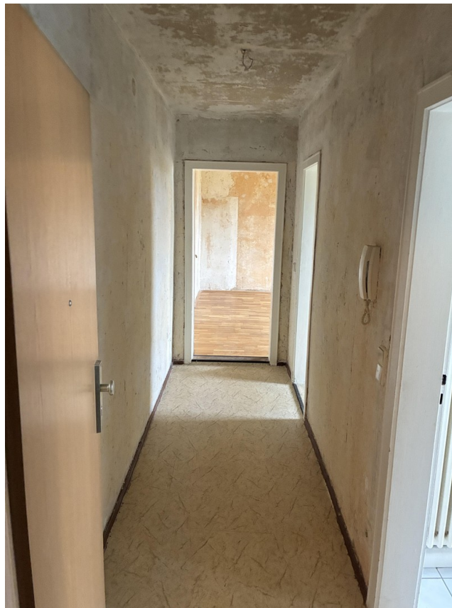
Flur mit Gegensprechanlage
