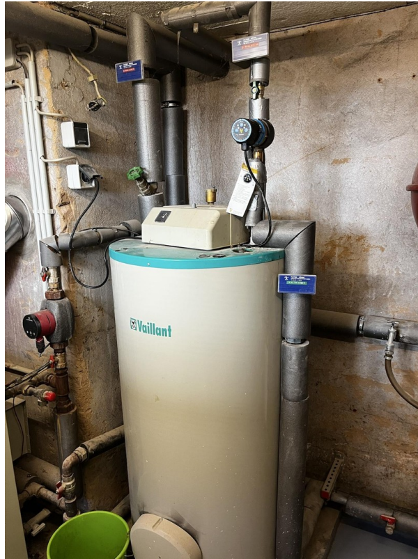
Warmwasserspeicher
