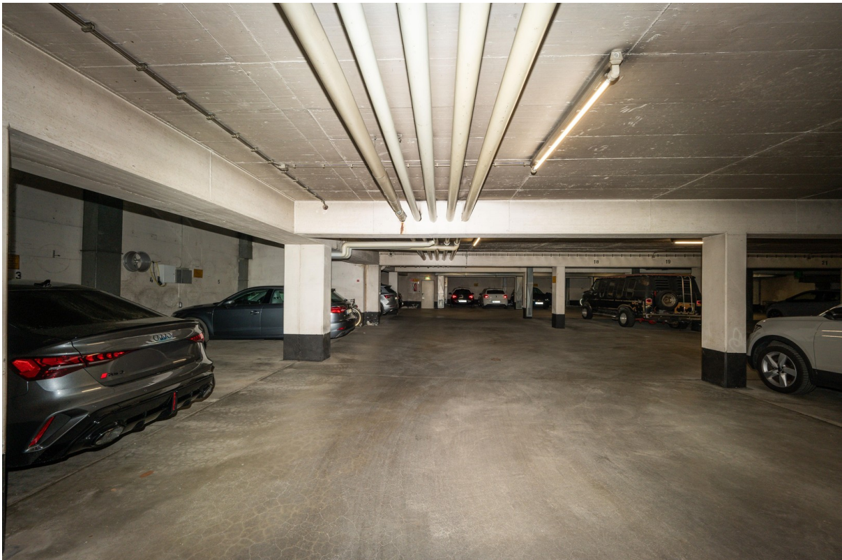
Blick in die Tiefgarage
