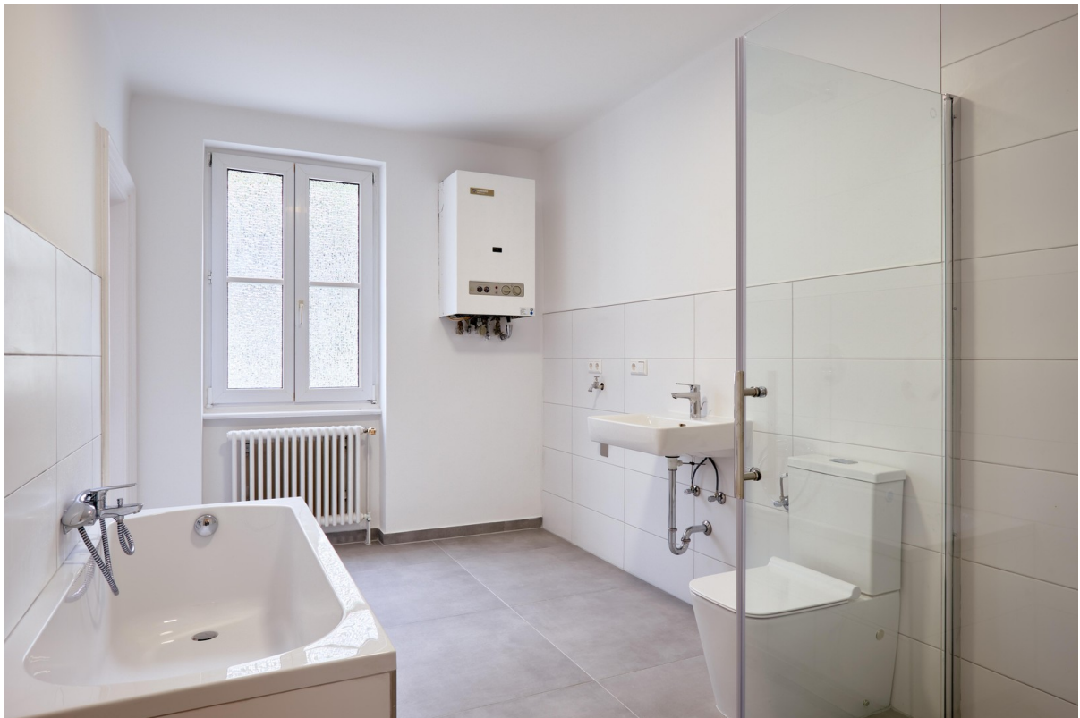
Blick ins Bad vom Flur
