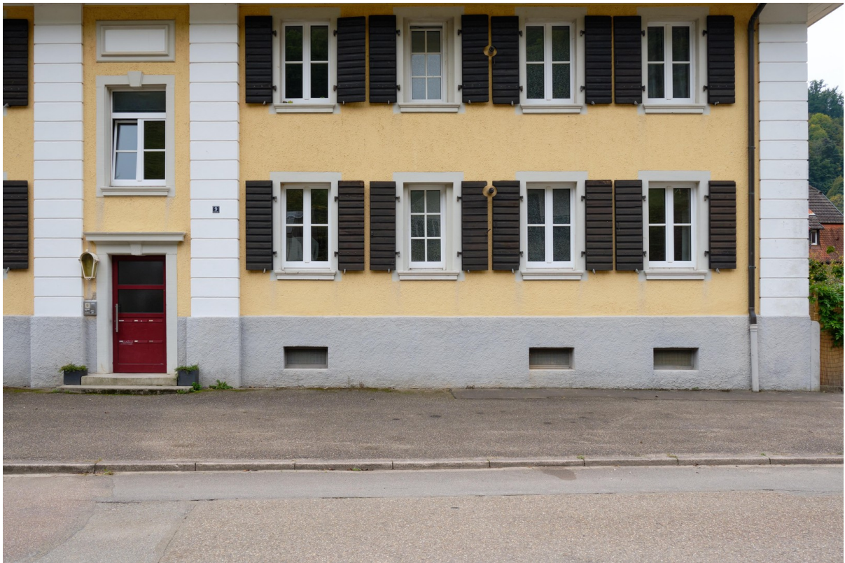
das Haus von der Straße aus
