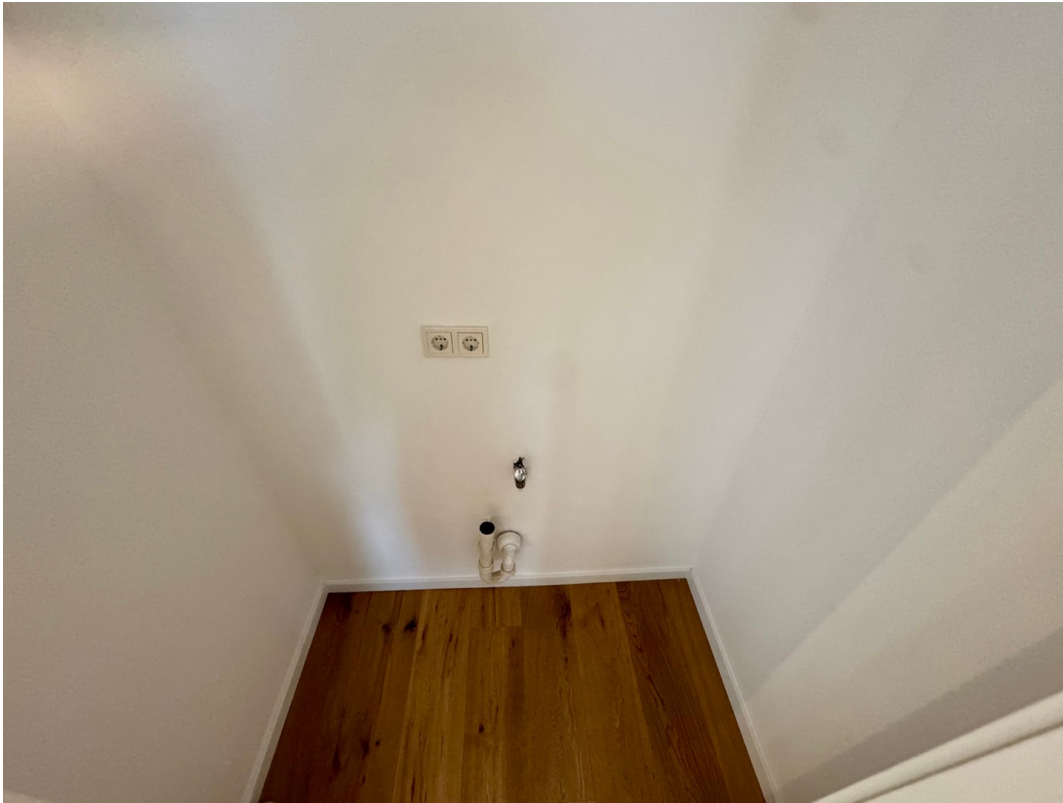
Abstellraum mit WM Anschluss
