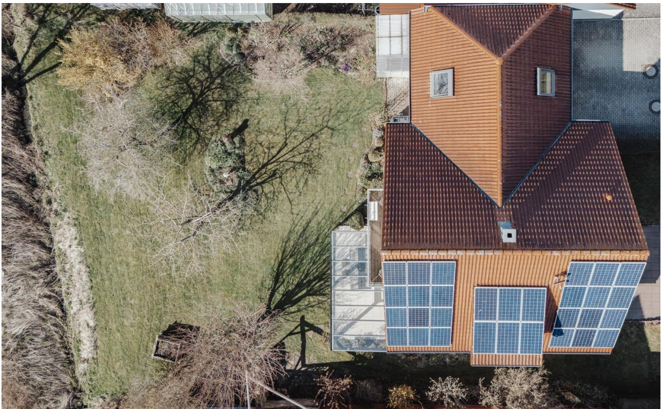
Dach mit Photovoltaik
