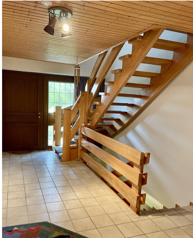
Treppenaufgang ins OG
