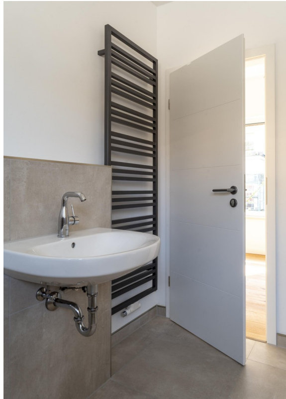
Bad Obere Etage
