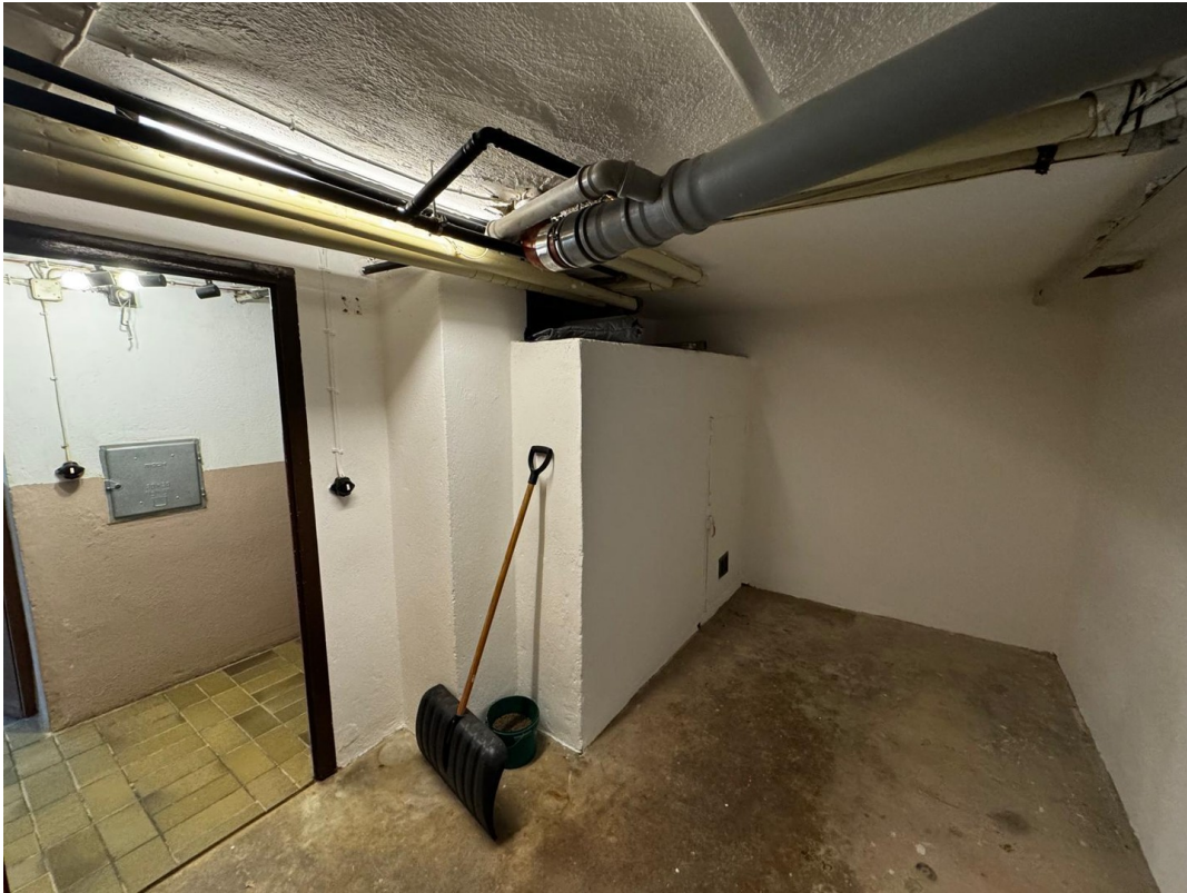
Abstellraum im Keller
