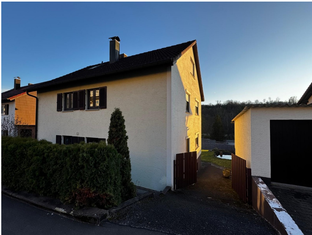
Außenansicht Haus Garage
