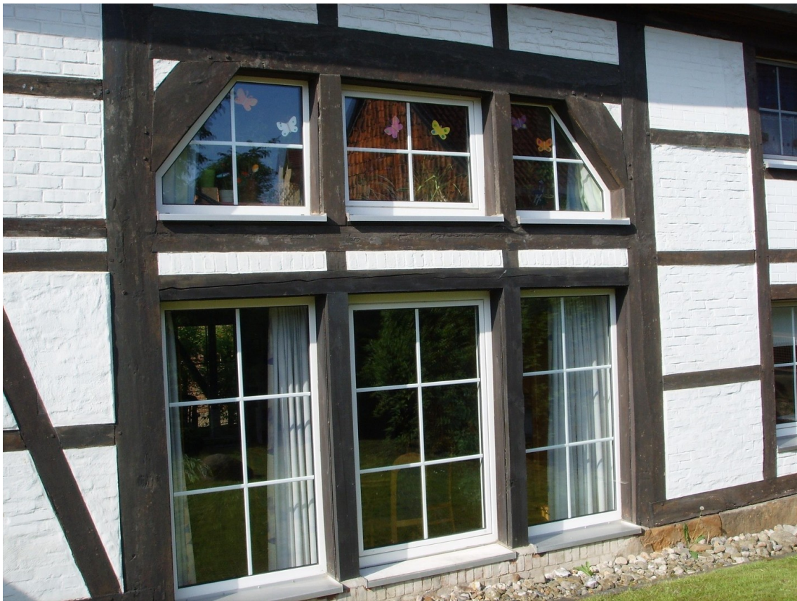
Fensterfront der Wohnung
